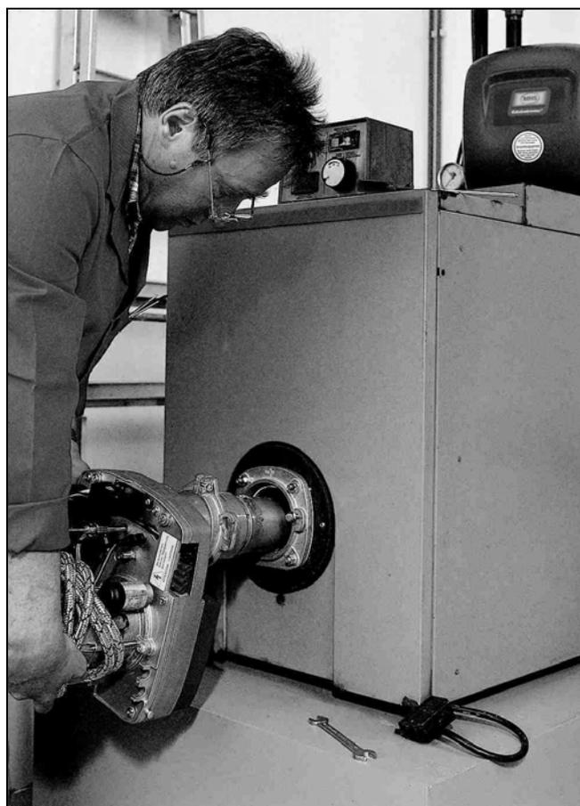
Fig. 7: Montaje quemador – caldera II
