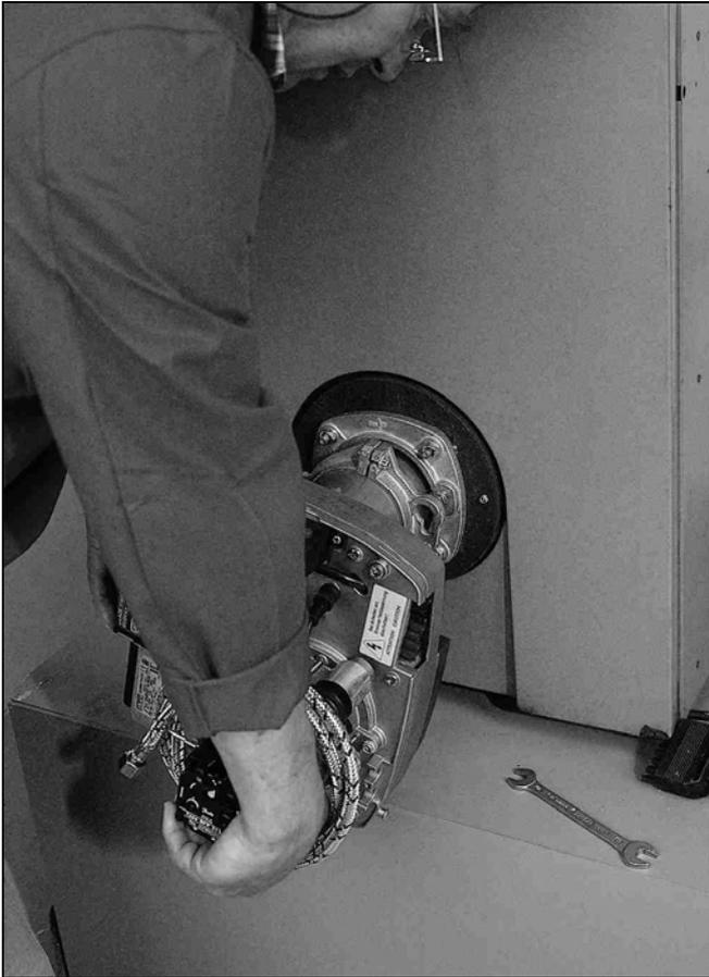
Fig. 8: Montaje quemador caldera III
