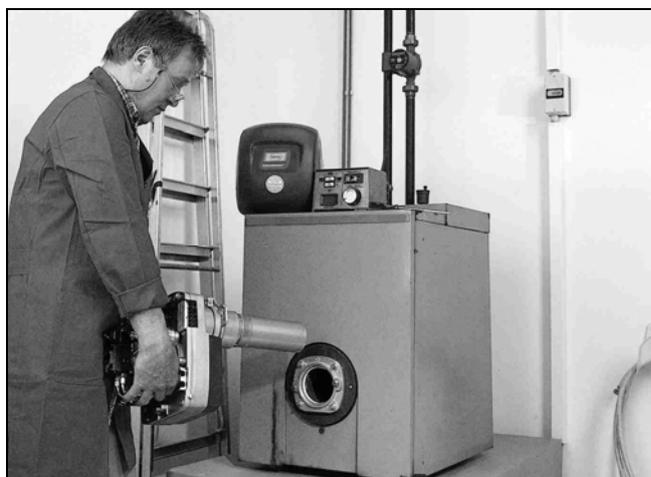
Fig. 6: Montaje quemador – caldera I
